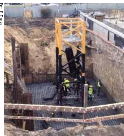
Montaż fabrycznie nowego żurawia wieżowego Liebherr 230HC-L8/16 Litronic na budowie KTW II w Katowicach. Na zdjęciu obok montaż kotwy
