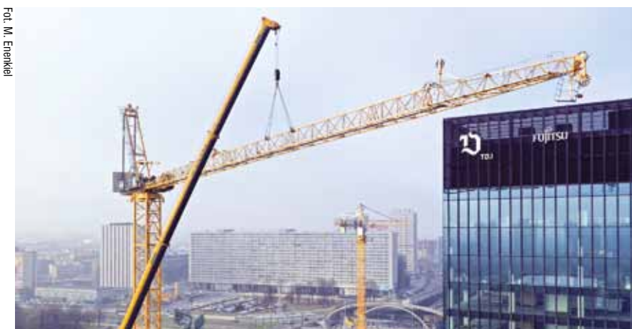
Montaż fabrycznie nowego żurawia wieżowego Liebherr 230HC-L8/16 Litronic na budowie KTW II w Katowicach. Na zdjęciu obok montaż kotwy
